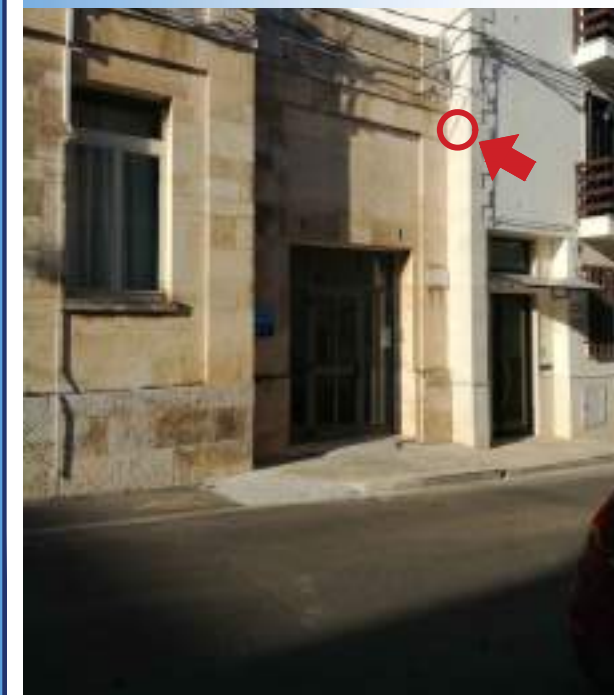
Foto sito di installazione telecamera
