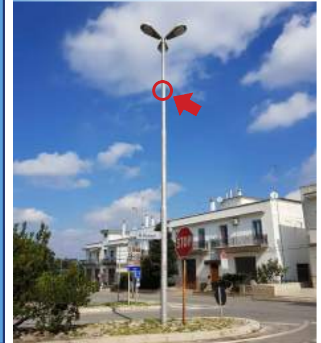
Foto sito di installazione telecamera
