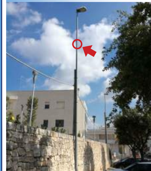
Foto sito di installazione telecamera
