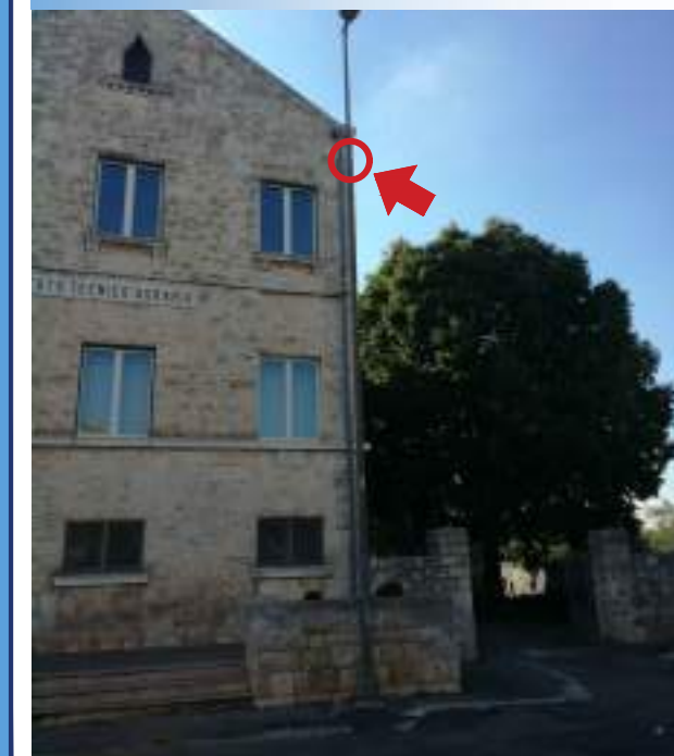
Foto sito di installazione telecamera
