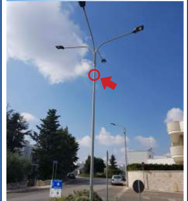
Foto sito di installazione telecamera
