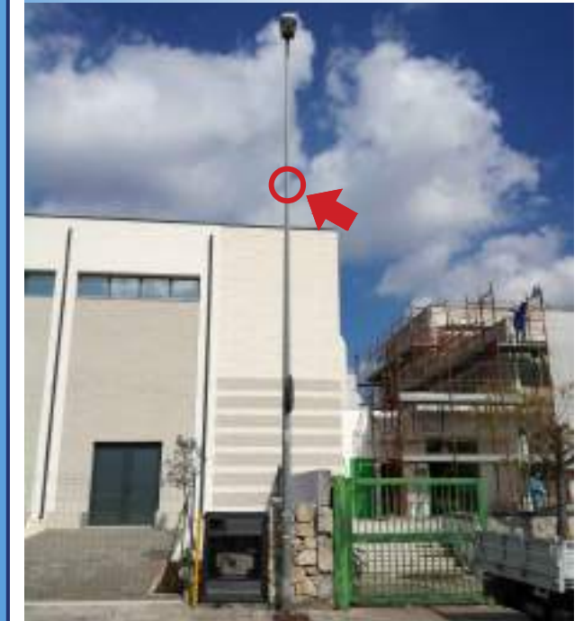
Foto sito di installazione telecamera
