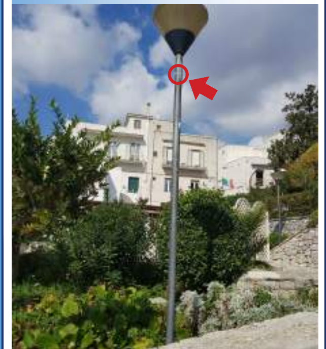
Foto sito di installazione telecamera
