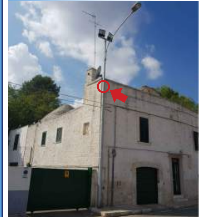
Foto sito di installazione telecamera
