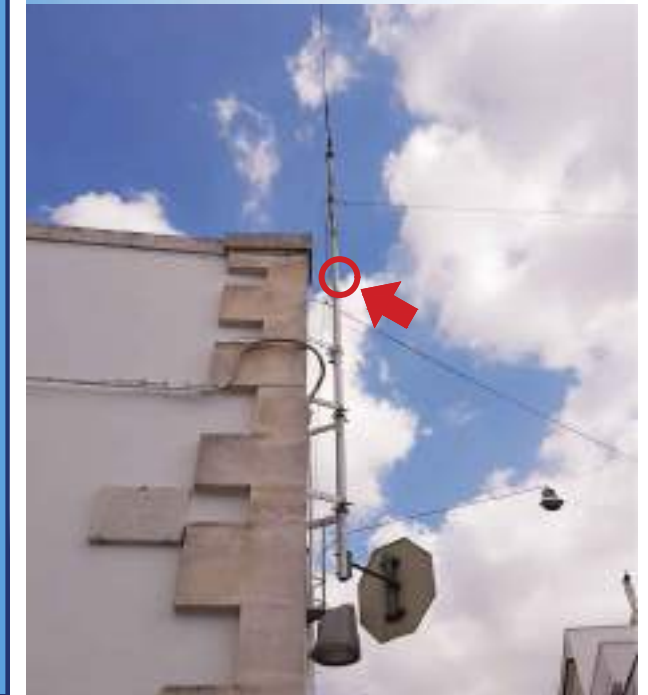
Foto sito di installazione telecamera
