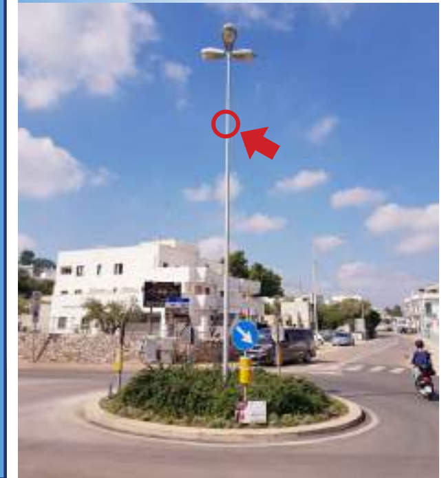
Foto sito di installazione telecamera
