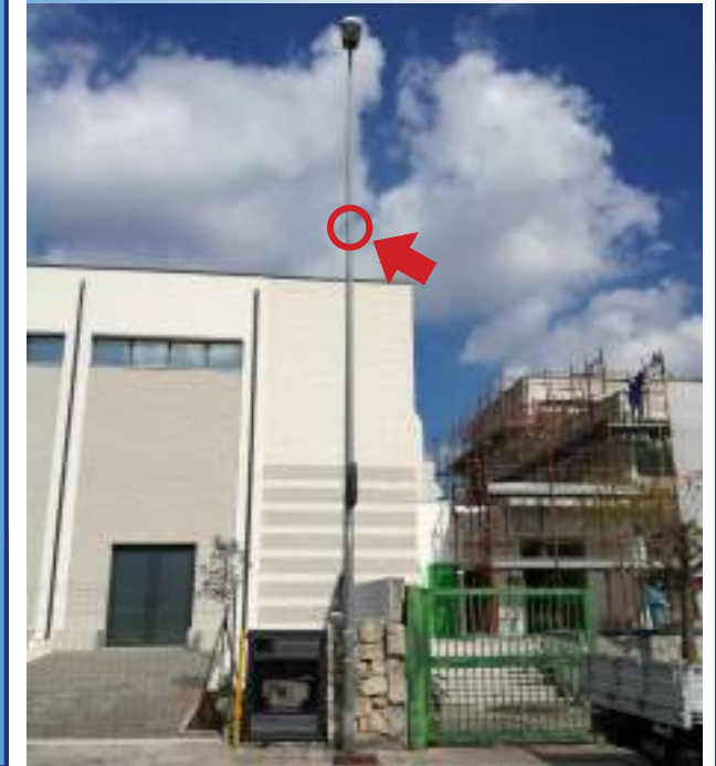
Foto sito di installazione telecamera
