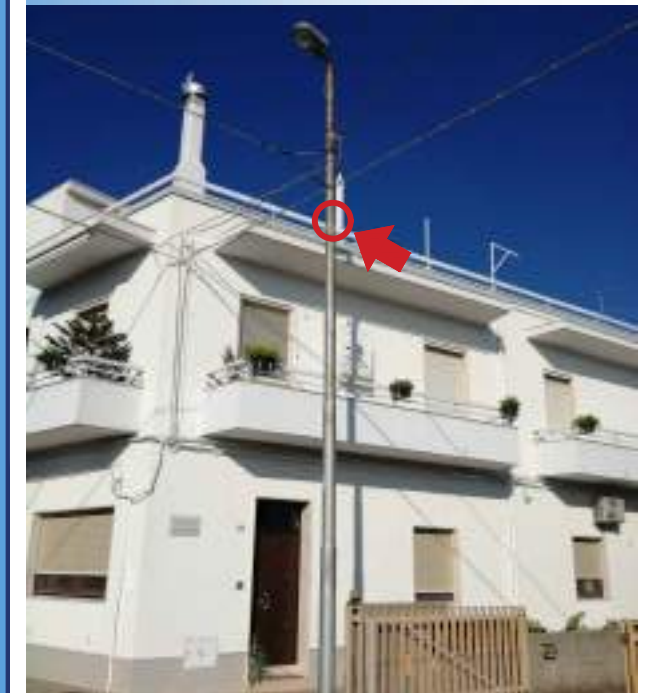
Foto sito di installazione telecamera
