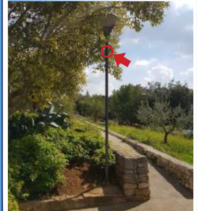
Foto sito di installazione telecamera
