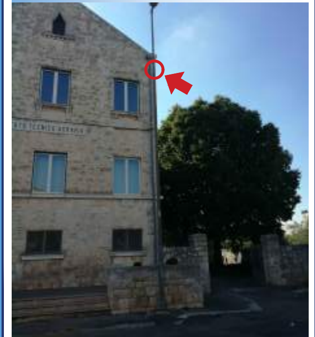
Foto sito di installazione telecamera
