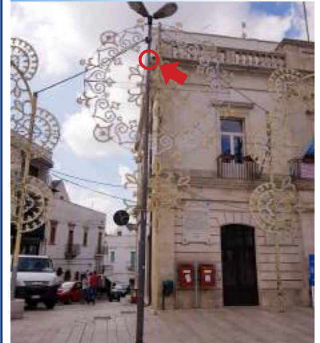
Foto sito di installazione telecamera
